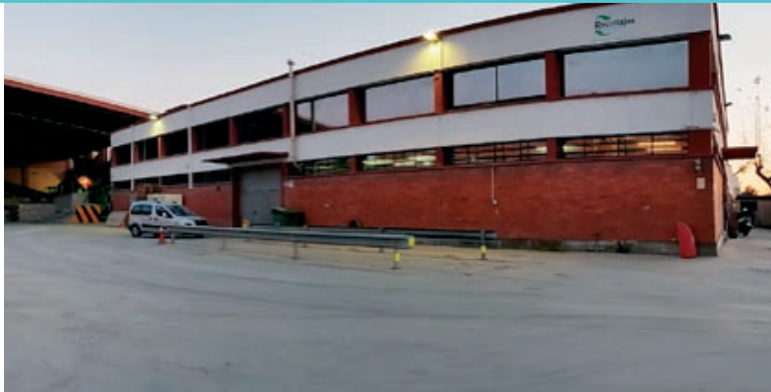
Les instal·lacions de Sant Fost acullen l'activitat de l'empresa des de l'any 2012
